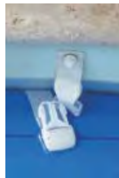
Hebilla antilevantamiento en pared
