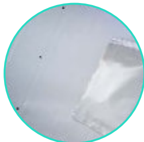
Orificios de desagüe de aguas pluviales
